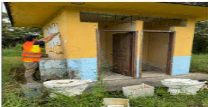
LIJADO EXTERIOR DE PAREDES Y PUERTAS
