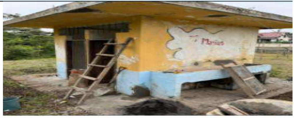
DESMONTAJE Y RETIRO DE PUERTA
